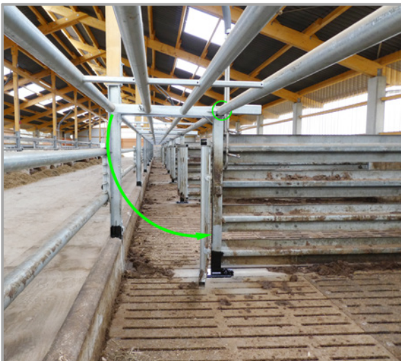
Abb. 10: Beispiel eines in die Bucht integrierten Treibganges, der durch Runterschwenken des oberen Gitters (s. Pfeil) an der Futtertischseite entsteht.
