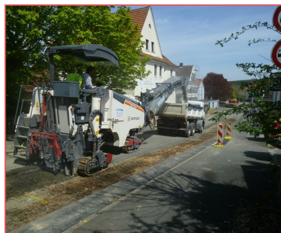
Sanierung der Ortsdurchfahrt Heinersreuth „Cottenbacher Straße“ (BT 14)
