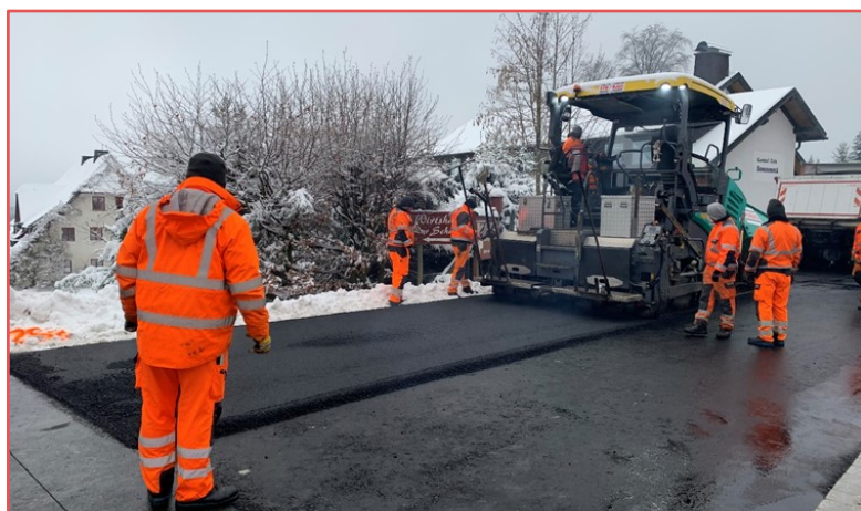
Erneuerung der Kreisstraße im Bereich Parkplatz Talstation Süd in und um Fleckl und Umbau Knotenpunkt mit der Ortsstraße „Vordergeiersberg“ (BT 4)
