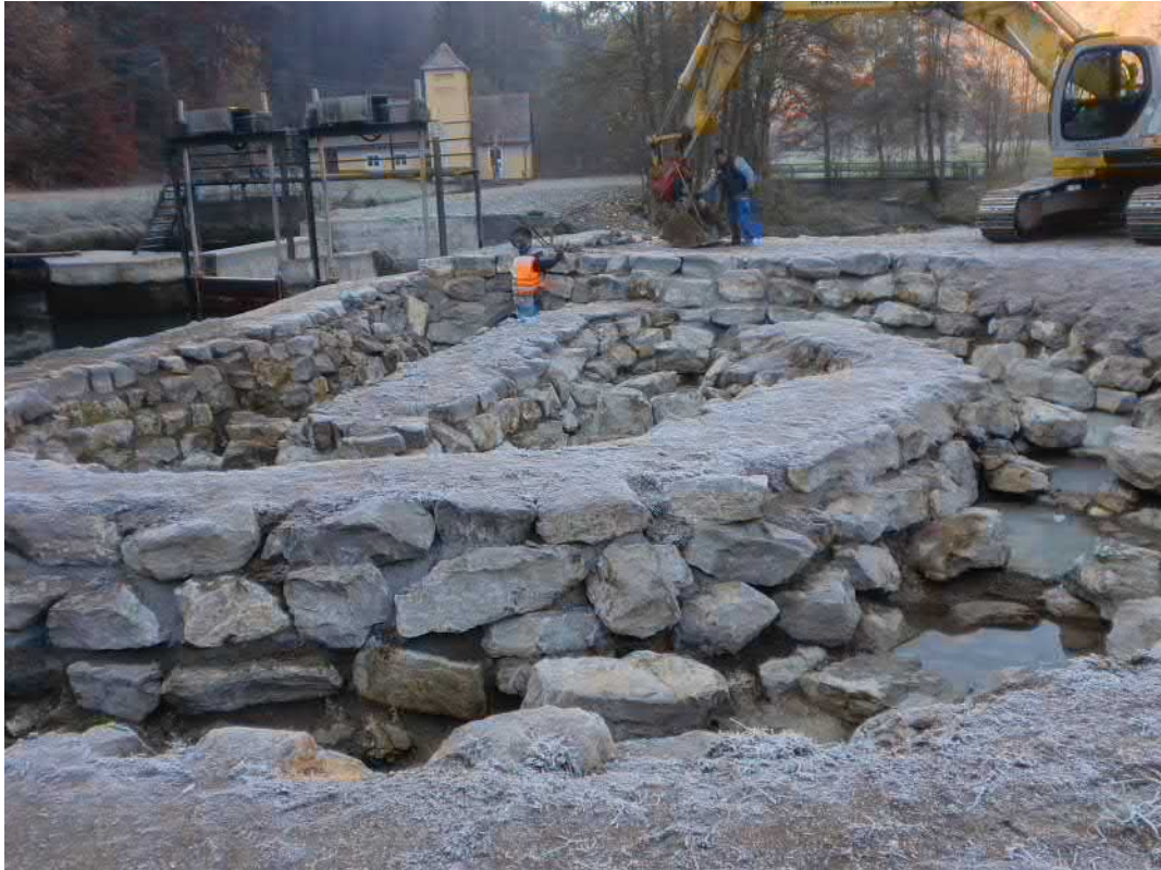
Bauphase der Fischaufstiegsanlage an der Wasserkraftanlage des Zweckverbandes zur Wasserversorgung der Köttweinsdorfer-Gruppe
