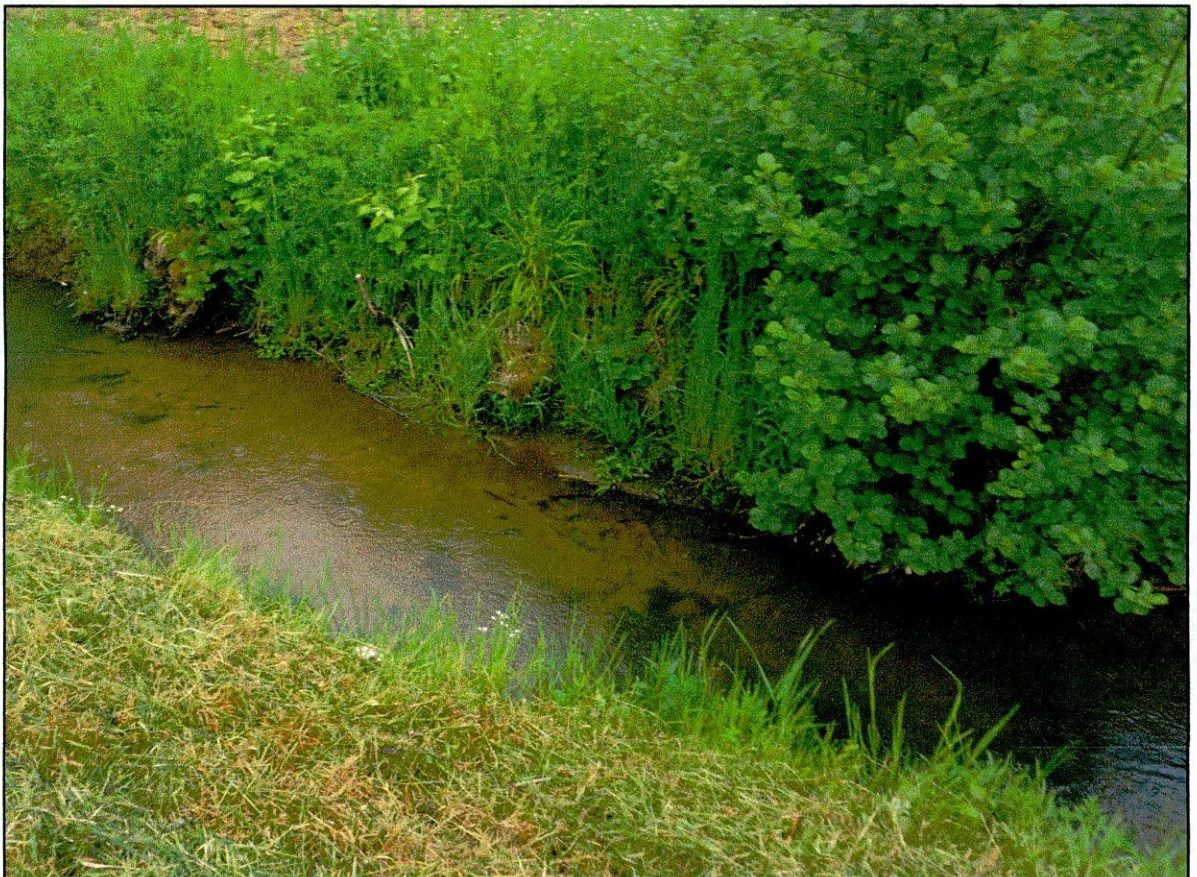
Bild 3: Sohle Erlichbach knapp oberhalb der geplanten Einleitstelle
