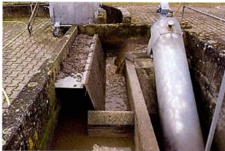
Abbildung 4.11: Rücklaufschlammumpwerk
