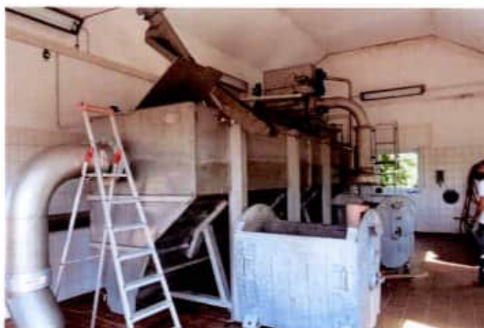
Abbildung 4.4: Sieb-Sandfang-Kompaktanlage
