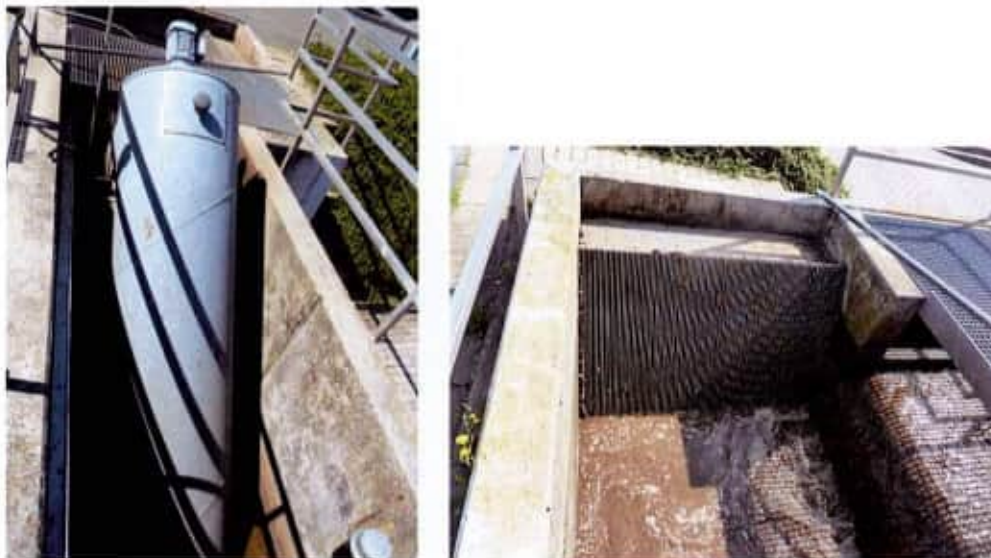
Abbildung 4.9: Rücklaufschlammumpwerk
