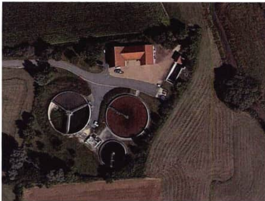
Abbildung 1: Luftbild der Kläranlage Hollfeld [1]
