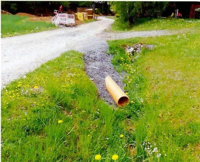
Abbildung 3: Einleitungsstelle 1, RRB Creußener Straße
