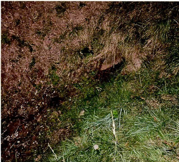
Abbildung 6: Einleitungsstelle 4 Regenwasserkanal am Friedhof
