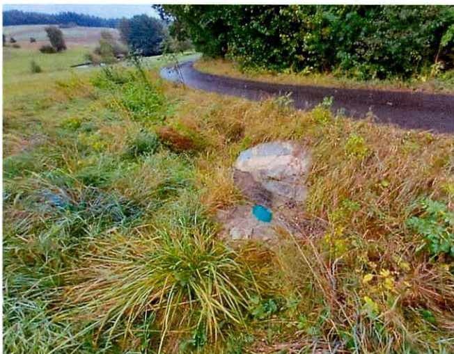
Abbildung 4: Einleitungsstelle 2, RRB Schnabelwaider Straße
