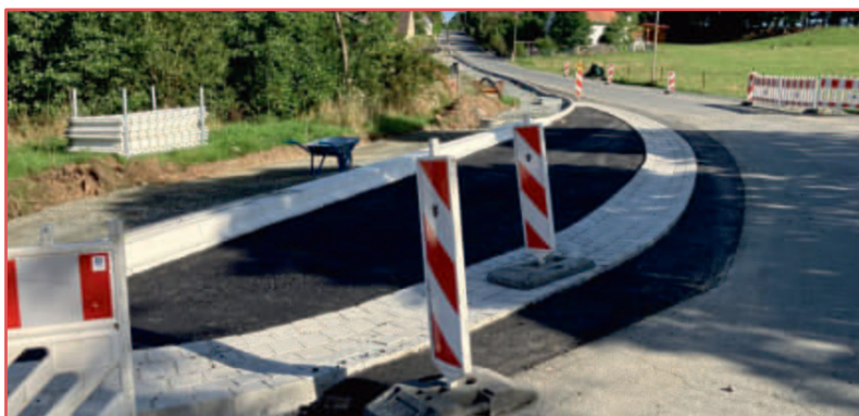
Sanierung und Anlage eines Gehweges an der BT 14 bei Theta (Gemeinde Bindlach)
