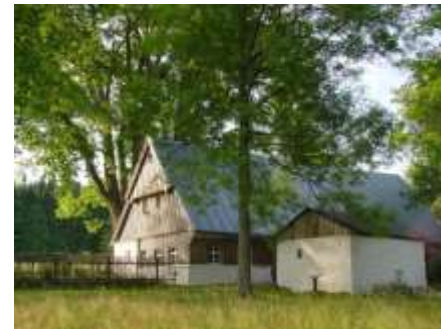
Freilandmuseum Grassemann bei Warmensteinach ( www.warmensteinach.de/Grassemann )
