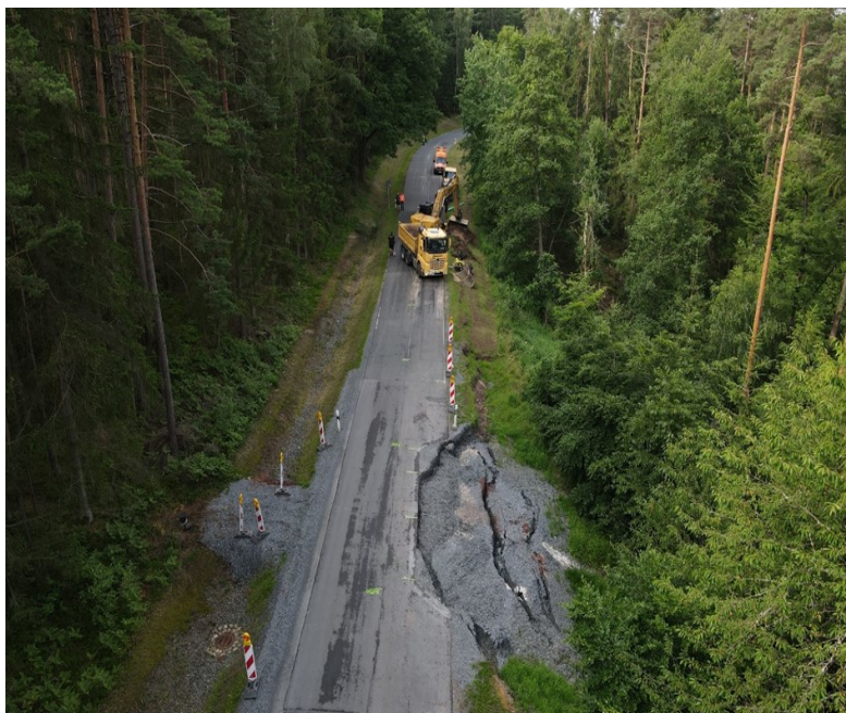
Sanierung Hangrutsch südlich von Theta
